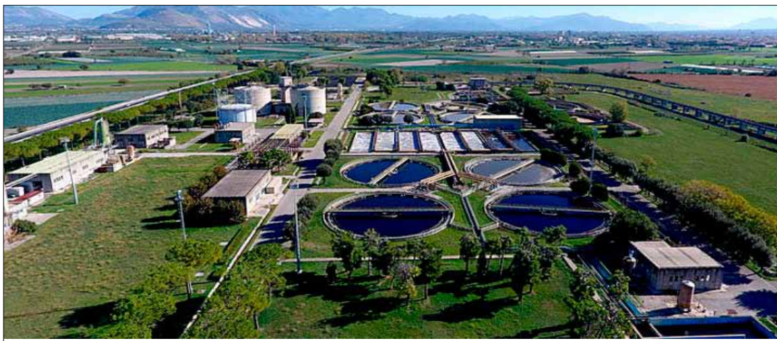
Estación de tratamiento de aguas en Acerra (Italia), que gestiona Depuración de Aguas del Mediterráneo (DAM). EE
