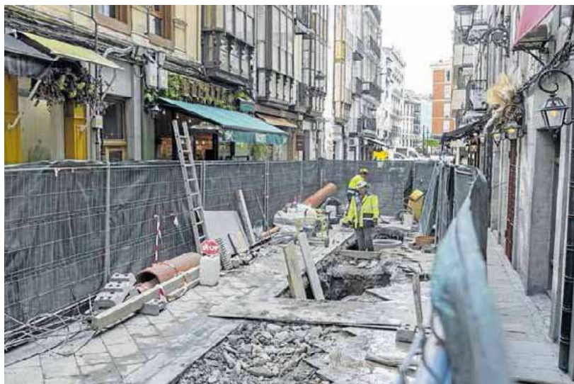
Operarios y maquinaria dentro del vallado de la santanderina calle del Medio. ROBERTO RUIZ
