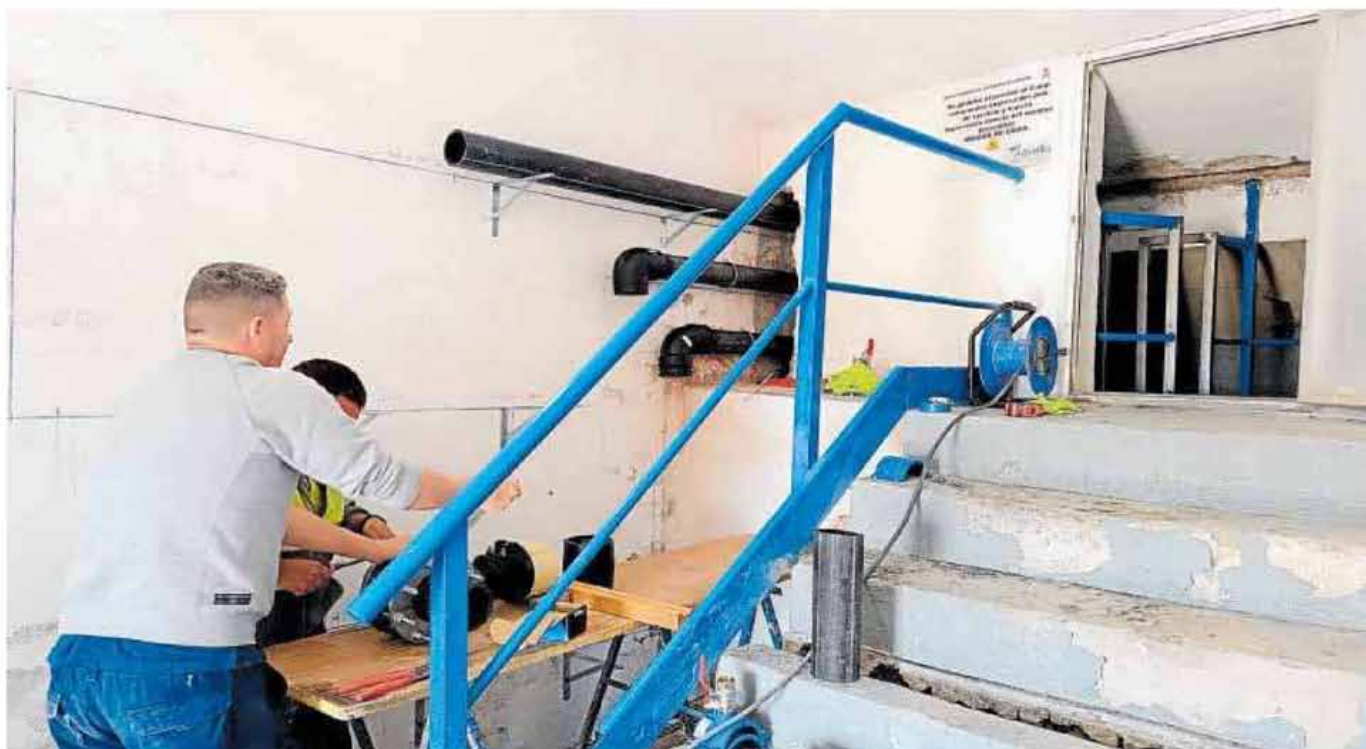
Operarios, concluyendo las obras de la tubería de La Joya y Castell del Rey. R. L.
