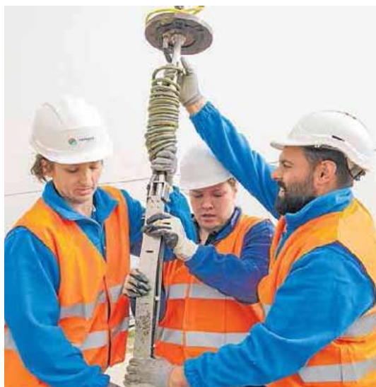
Operarios meten el dispositivo de detección de fugas en una tubería. SUR
