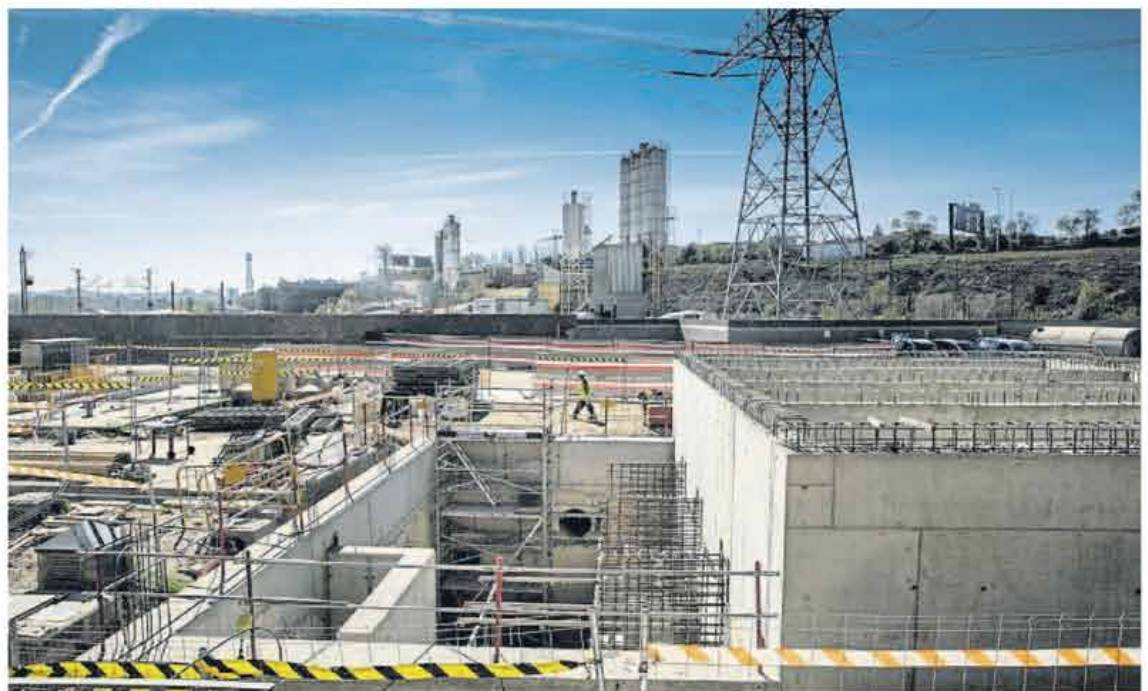
Obras de ampliación de la estación de tratamiento de agua potable del Besòs
